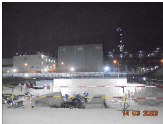
ค) กันเขตพร้อมติดตั้งไฟส่องสว่างบริเวณพื้นที่ก่อสร้าง
