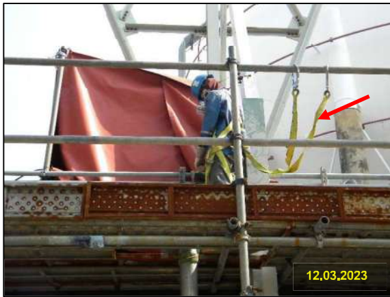
ค) อุปกรณ์ป้องกันการตกจากที่สูงขณะปฏิบัติงาน
