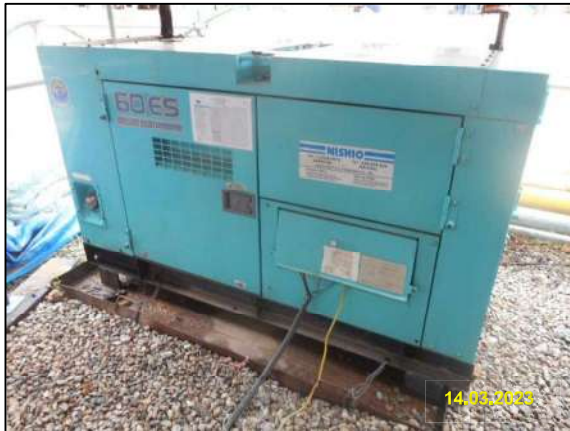
ก) ตู้เหล็กรอบเครื่องยนต์เพื่อลดระดับเสียง
