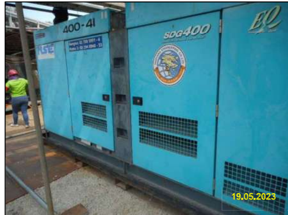
ก) ตู้เหล็กรอบเครื่องยนต์เพื่อลดระดับเสียง
